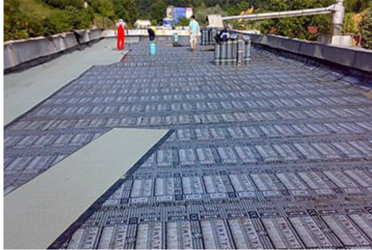
Битумна хидроизолация в два пласта
