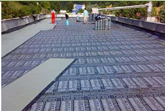
Битумна хидроизолация в два пласта
